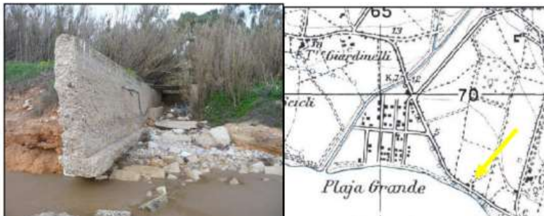
Foto a sinistra: tratto terminale canale pluviale della SP n° 89, si notano i livelli prevalentemente rocciosi arrossati a destra e a sinistra della struttura. Sullo sfondo, oltre il canneto, e quindi ben lontano dalla costa , si intravede il nastro viario. Immagine a destra, stralcio carta IGM 1967, si nota che in questo punto la spiaggia è sempre stata poco profonda.
